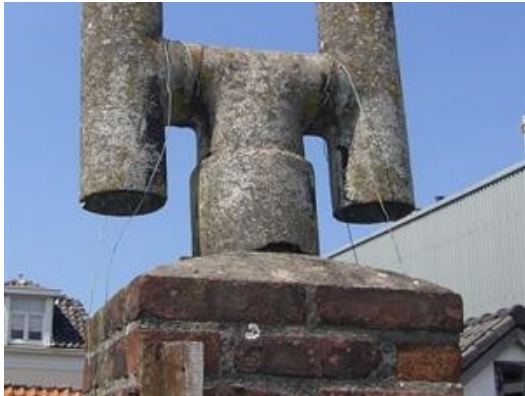
Asbesthoudende schoorsteenkap
