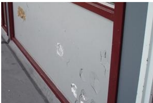
Asbesthoudende gevelbeplating
