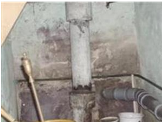
Asbesthoudende standleiding
