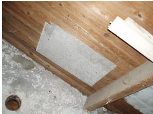
Asbesthoudende beplating
