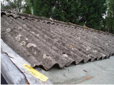
Asbestcement golfplaten
